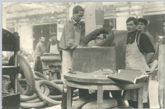
Одевание браслета на рабочую камеру вручную.
