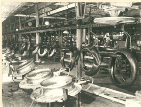
ПОДАЧА ВУКАНИЗОВАННЫХ КАМЕР НА ПОДВЕСНОМ КОНВЕЙЕРЕ НА УЧАСТОК МОНТАЖА
