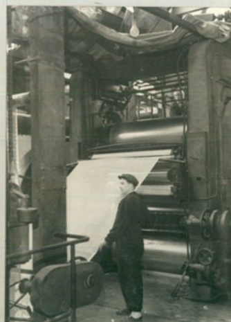
Заправка корда в зазор каландра.
