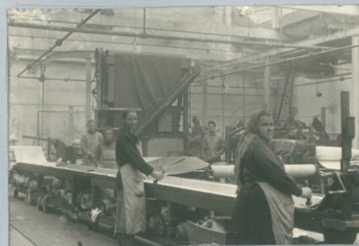
Закатка накроенных полос прорезиненных тканей в валики вручную.
