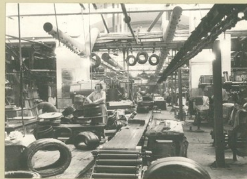
Общий вид зала для сборки покрышек. На переднем плане транспортер для транспортировки деталей и собранных покрышек.
