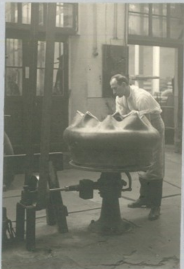
Сборка каркаса на металлическом дорне
