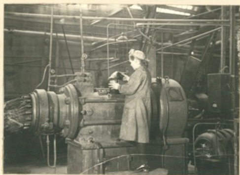
Червячный фильтр-пресс для стрейнирования камерных резин в целях их очистки.
