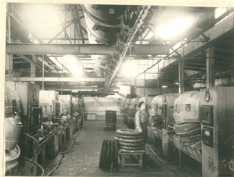
Группа индивидуальных вулканизаторов для покрышек. Пресс вулканизации полностью механизирован и автоматизирован.
