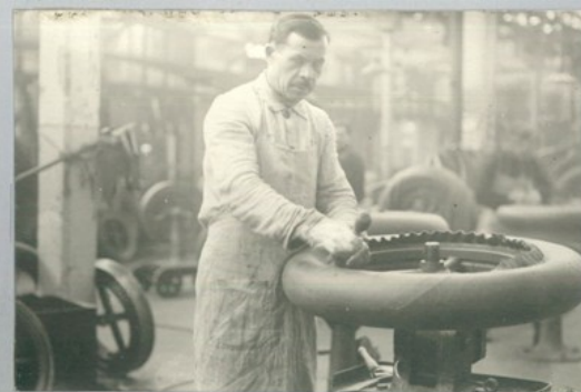
Прикатка последнего слоя.
