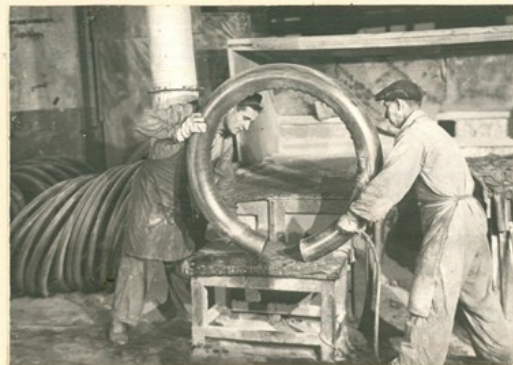
ПОДГОТОВКА КАМЕР К ВУКАНИ- ЗАЦИИ В КОТЛАХ. ОДЕВАНИЕ НА ДОРН ВРУЧНУЮ.
