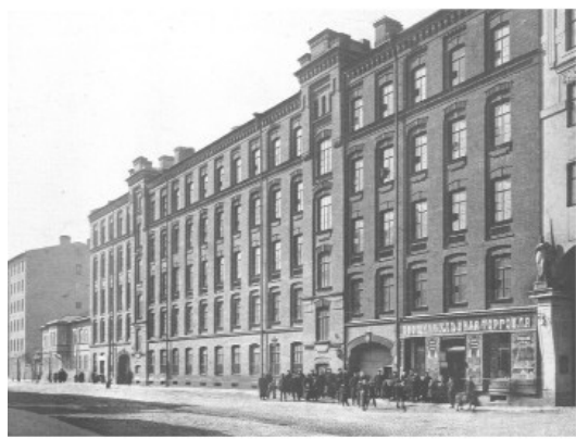
Квартиры для рабочих в Санкт-Петербурге
