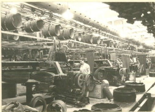
Подвесной конвейер в сборочном цехе для невулканизованных покрышек
