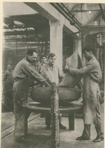
Закладка варочных камер в дорновую покрышку на ручном станке. (1930-ые годы)
